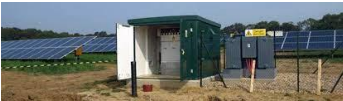
Insert 1: Switchgear
